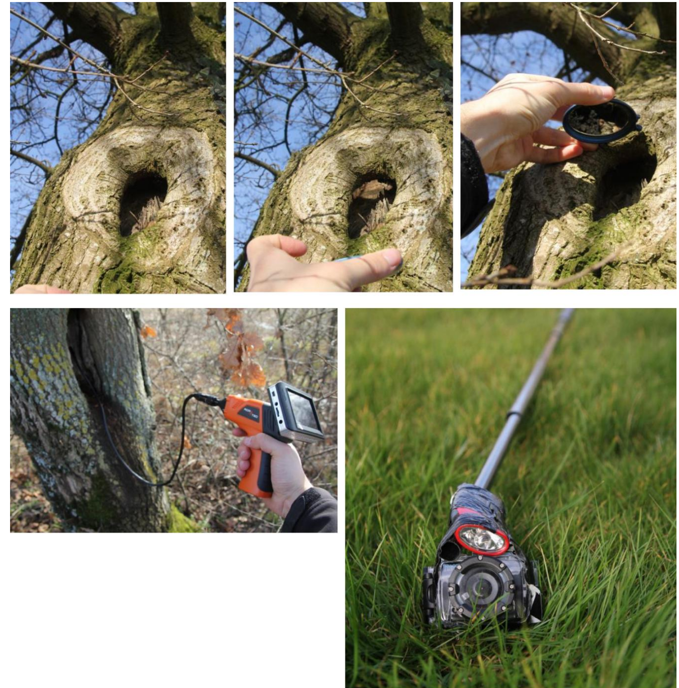
Figure 33 : techniques utilisées pour la vérification de cavités
